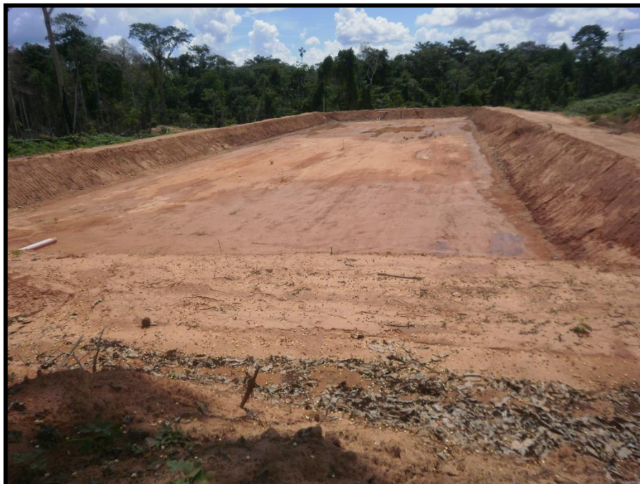
Figura 13: Aterro sanitário: célula receptora do chorume tratado. Fonte: MESQUITA: Andréia Pereira (2010).
