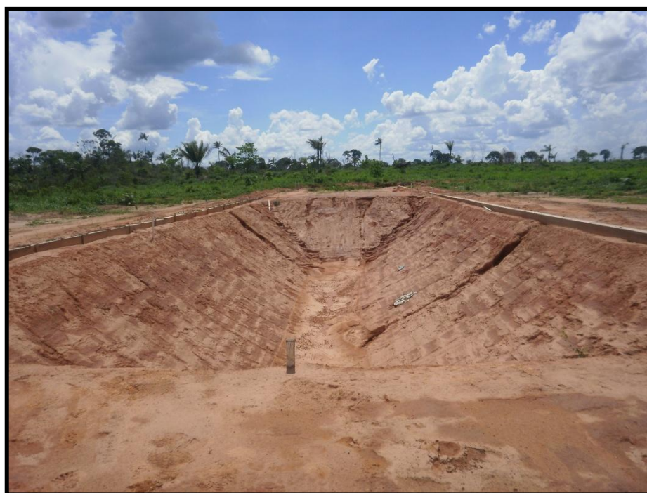
Figura 14: Aterro sanitário: célula da saúde que se tornará receptora de lixo hospitalar. Fonte: MESQUITA, Andréia Pereira (2010).
