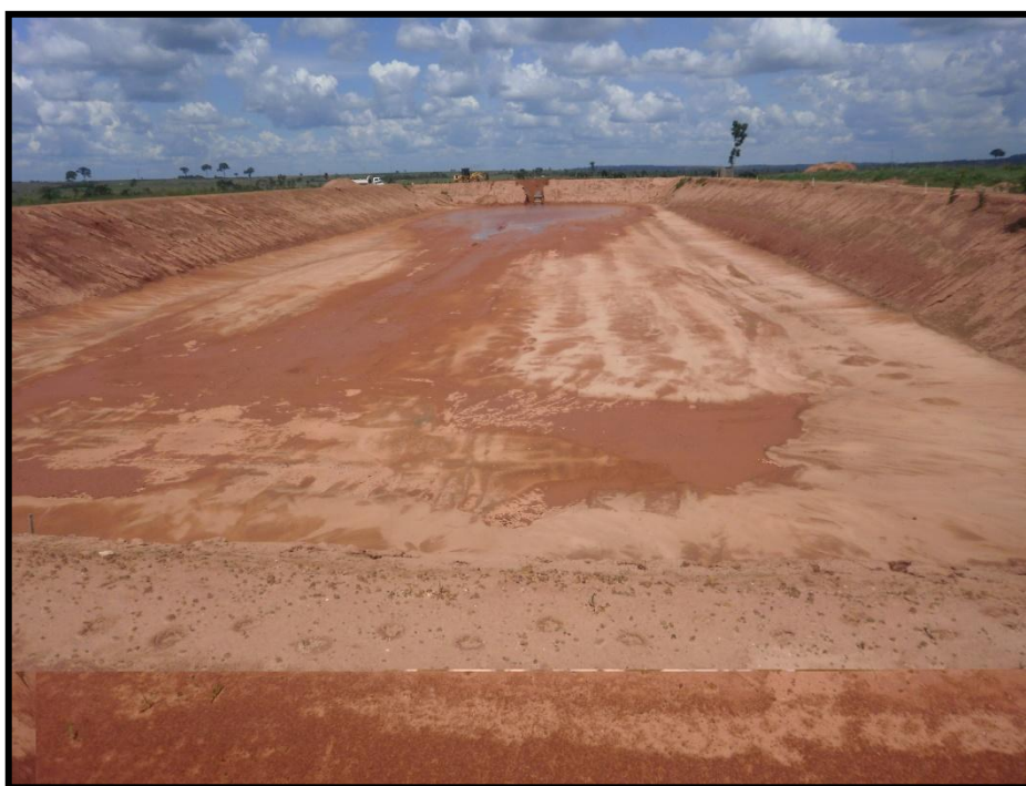
Figura 12: Aterro sanitário: célula que se tornará receptora de lixo doméstico. Fonte: MESQUITA, Andréia Pereira (2010).
