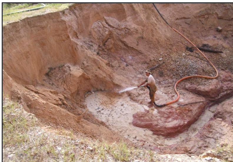
Figura 11. Processo de desmonte hidráulico, através do uso da mangueira de alta pressão.
