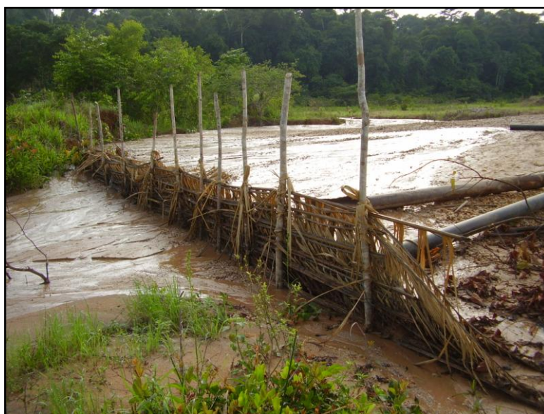
Figura 14. Barragem para contenção dos rejeitos. Fonte: LEMES, Denise Peralta (2009).
