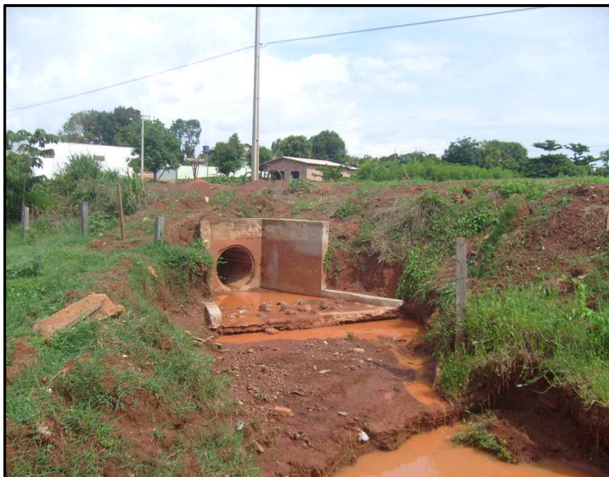
Figura 16: canalização das águas da chuva para a área de APP. Fonte: LUZ, 2010.
