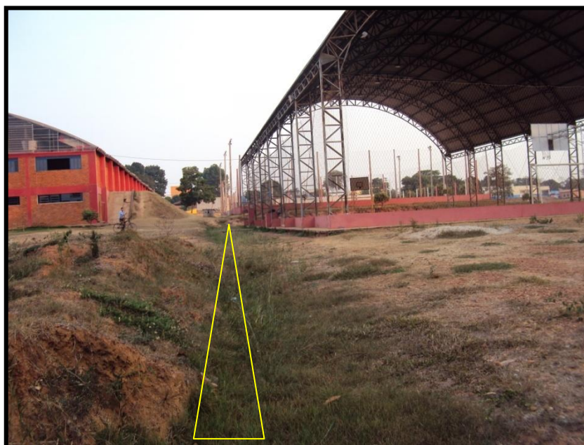
Fig. 11: Área erodida. Fonte: IZAC, 2010
