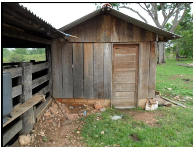
Fig. 35. Sala do resfriador. Fonte: ROCHA, Josemir Paiva, 2010.
