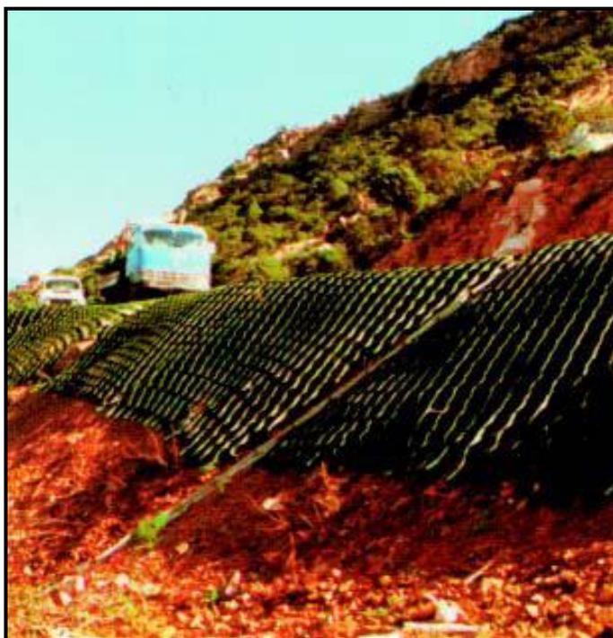
Fig.10: Tela metálica para estabilização da encosta.
