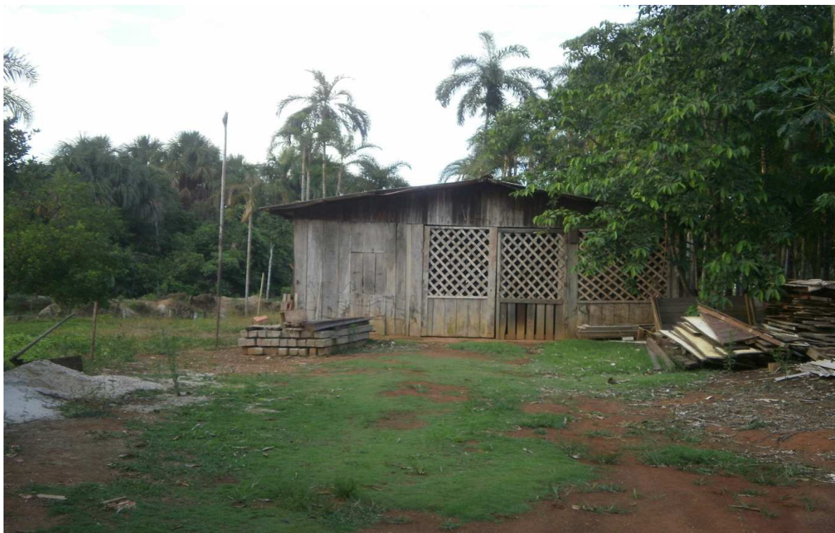
Figura 03 galpão p/ armazenagem de insumos.
