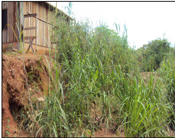
Figura 4: Construção irregular nas margens do córrego. Fonte: Leite, 2013.
