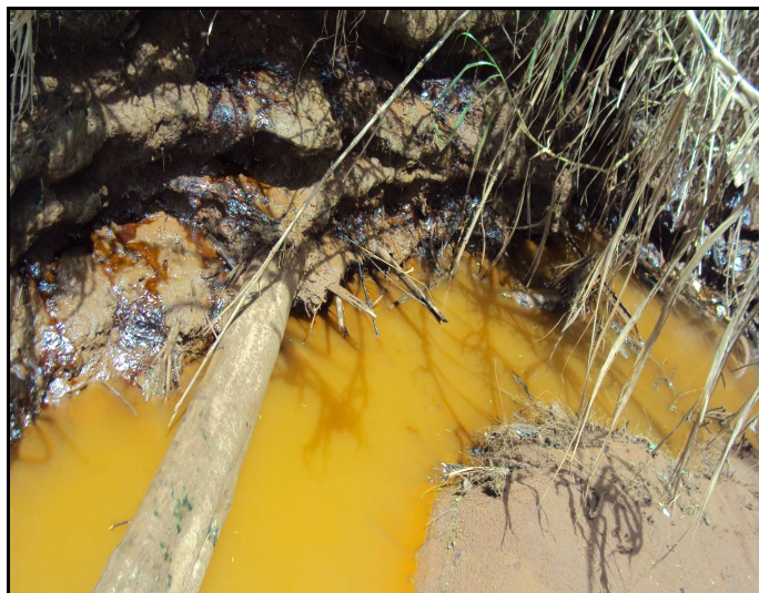
Figura 9: Outro exemplo de tubulação de esgoto domiciliar lançada no córrego. Fonte: Leite, 2013.
