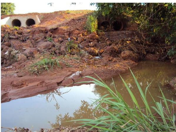
**Figura 5:** Desvio do leito do córrego afluente Do rio perdido
