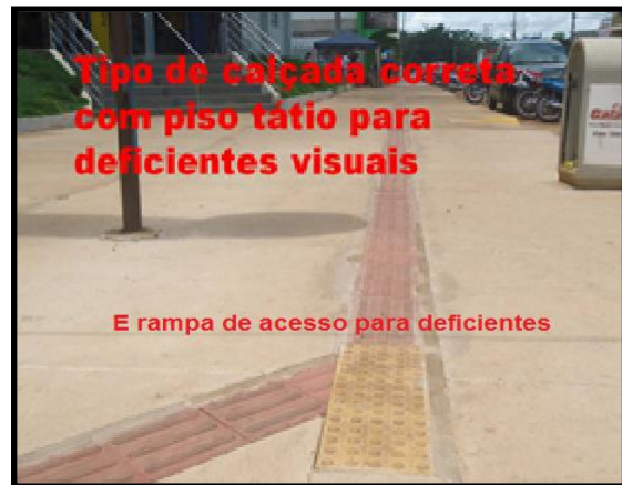
Calçada com rampa e piso tátil
