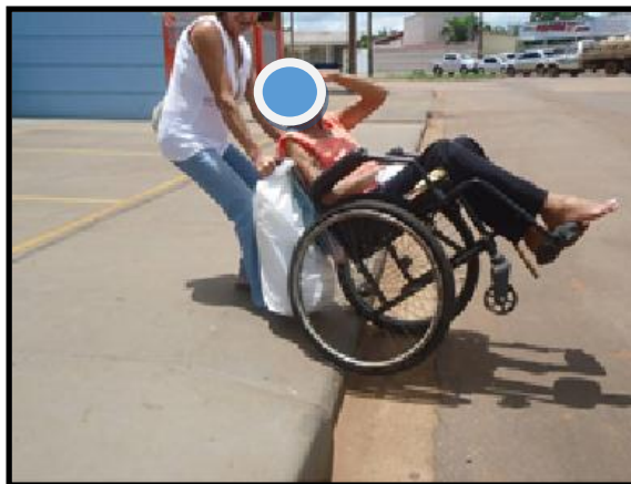
Figura 28: Calçada sem rampa de acesso Fonte: Figueiredo (2013)
