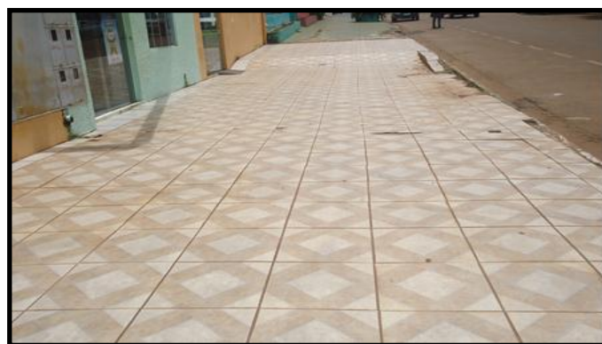
Figura 22: Calçada com piso escorregadio Av. Mato Grosso Fonte: Figueiredo (2013)
