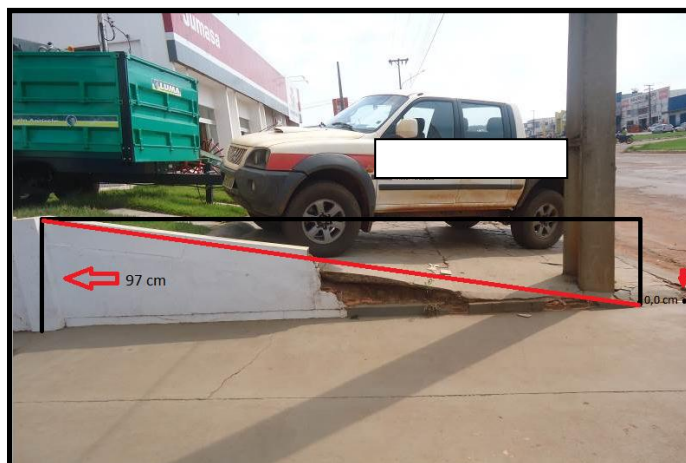
Figura 17: Calçada com alto grau de desnível na Av: JK (BR) Fonte: org. Figueiredo (2013)
