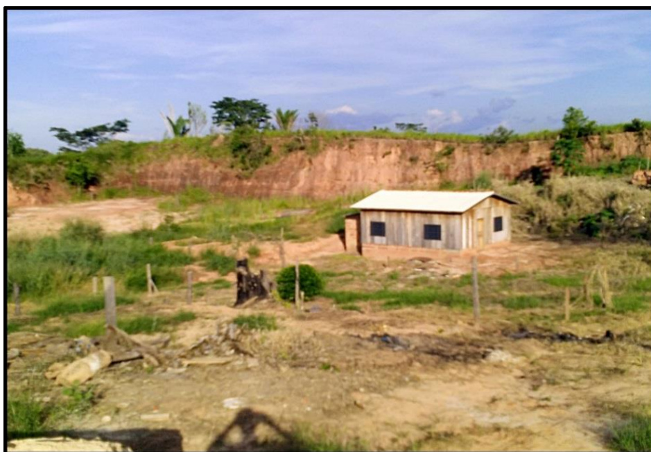
Figura 6 - Moradia construída Fonte: Silva, (2016).
