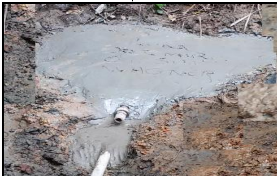
Figura 09: Proteção com cimento do reservatório da nascente Recuperada.
